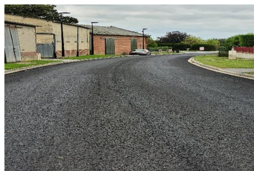
Rue du Maréchal HERLEVILLE
