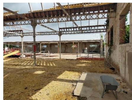
Photos construction de la médiathèque Intercommunale
