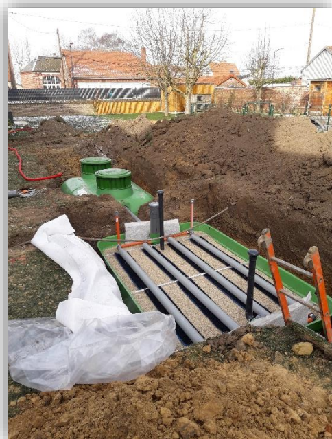
h a ntier de pose de filière compacte
